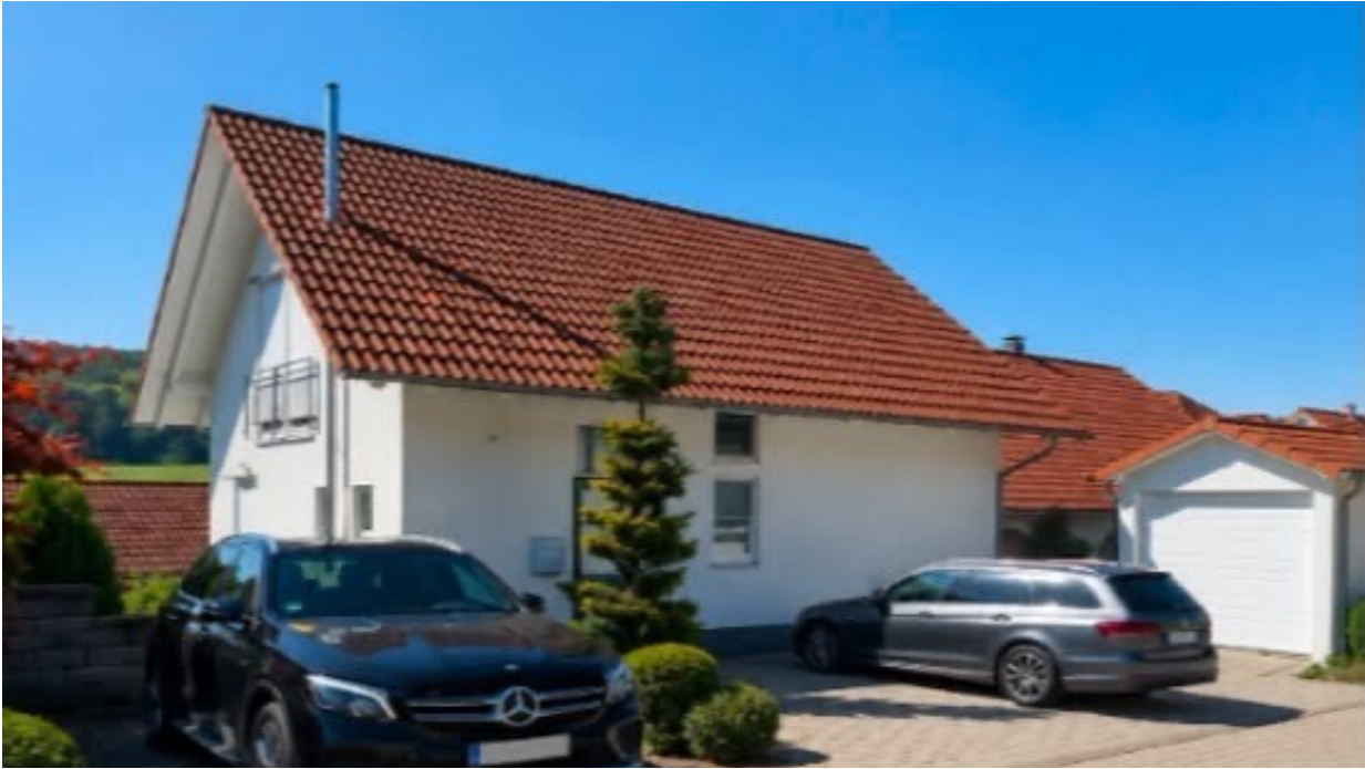
Haus mit Garage und Stellplätze
